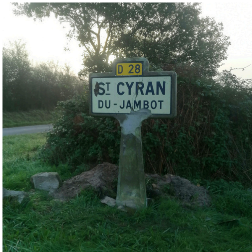
Réparation du panneau d'entrée de commune au lieu-dit La Touche par M. TRANQUART
